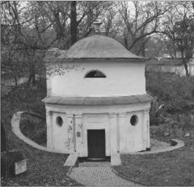
Будівля водяного млина в Парку декабристів. м. Кам'янка.
