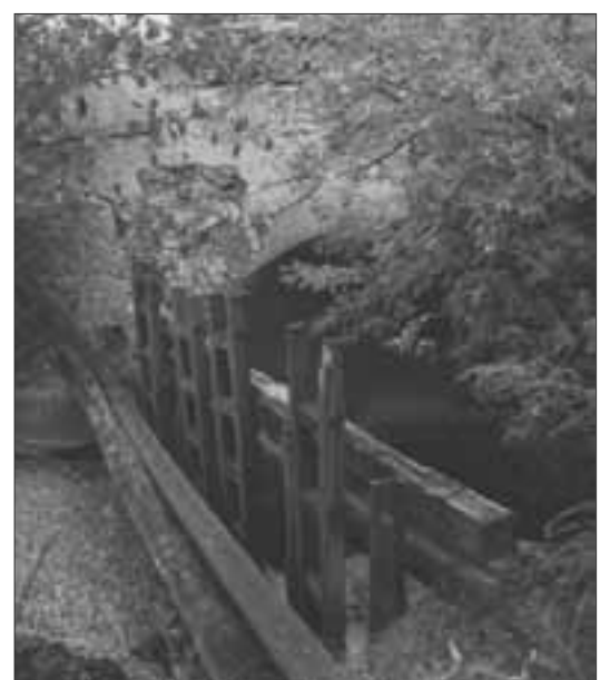
5. "Турецький міст" вище водоспаду. Для забезпечення греблі від прориву перед мостом знаходиться "опуст", який при потребі піднімають або опускають. Фото автора, 2009 р. The "Turkish bridge" upstream from the waterfall. To avoid the dam failure there is a lock before the bridge that can be moved up or down when needed. Photo by the author, 2009.
