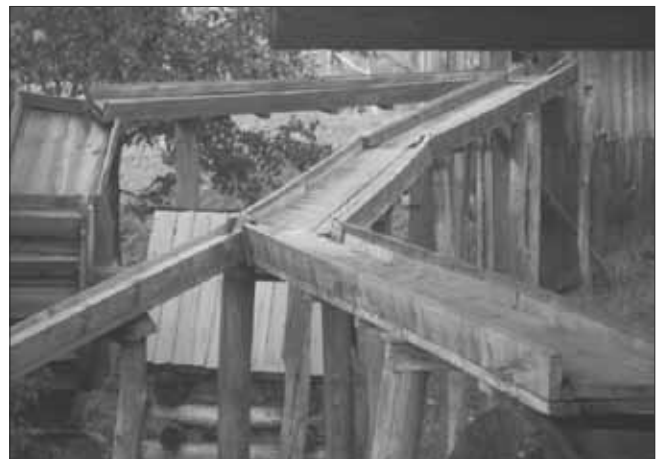
Дерев'яні жолоби ("лотки"), якими вода подається на колесо.
