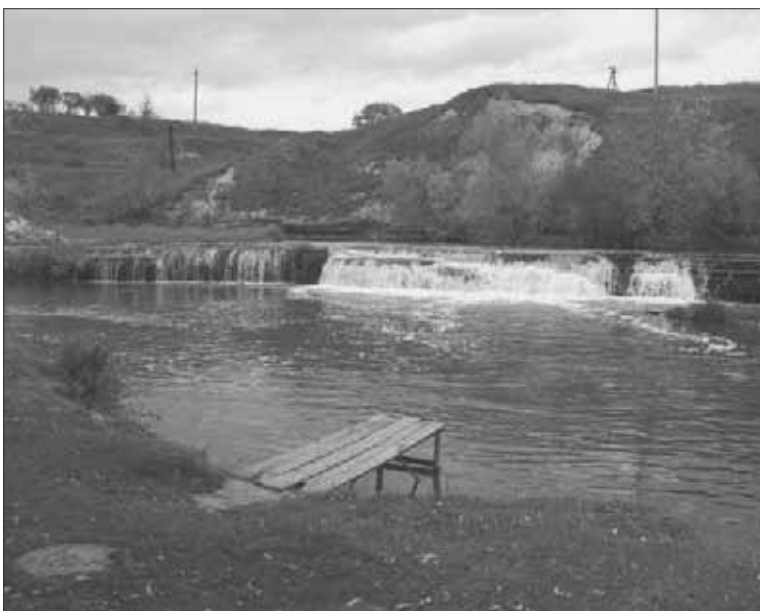
5. "Турецький міст" вище водоспаду. Для забезпечення греблі від прориву перед мостом знаходиться "опуст", який при потребі піднімають або опускають. Фото автора, 2009 р. The "Turkish bridge" upstream from the waterfall. To avoid the dam failure there is a lock before the bridge that can be moved up or down when needed. Photo by the author, 2009.
